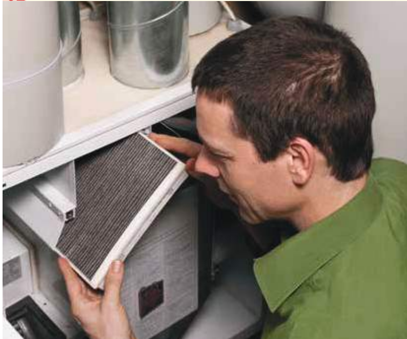
Havalandırma ünitesinin filtresinin değiştirilmesi.
