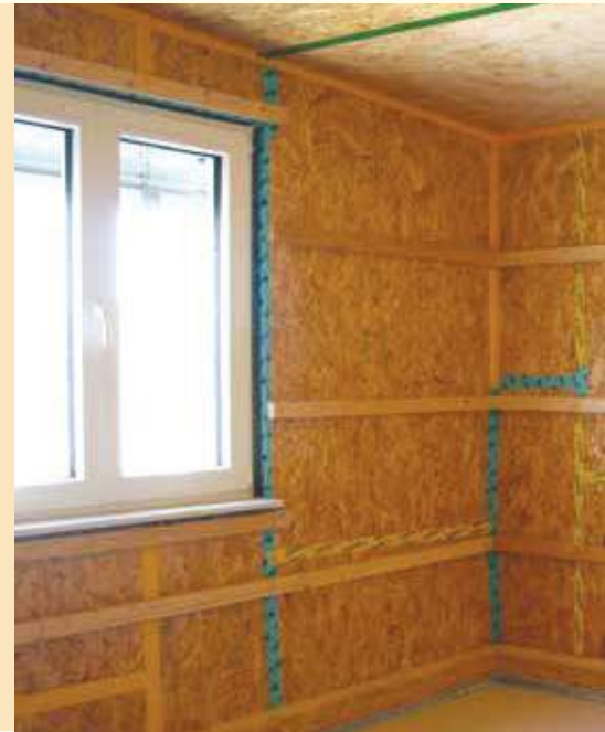
Ahşap kompozit levhalar arasında hava geçirmez bağlantılar
